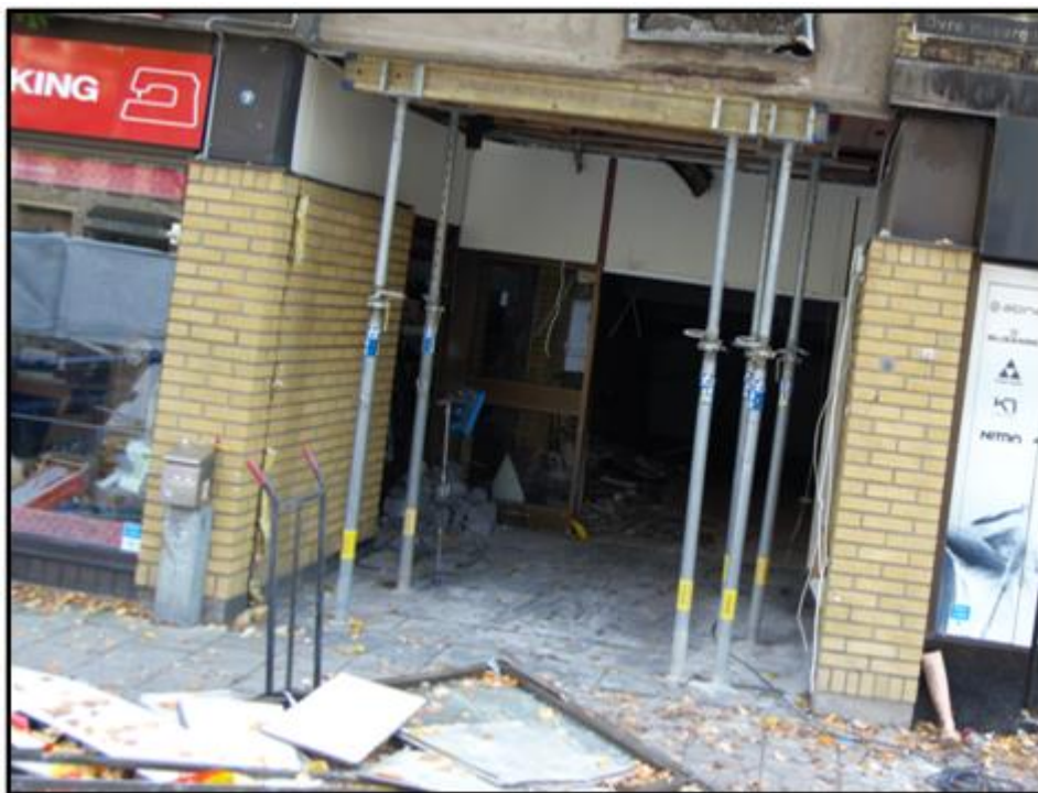
Figur 27 visar entrén med stämp, Källa RSG
