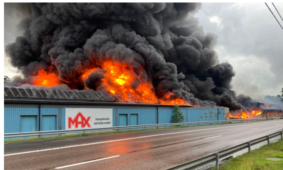
Brand i försäljnings- och lagerlokal i Källered.
